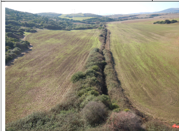
L'alveo del fiume santo a monte della Strada provinciale per Stintino.
