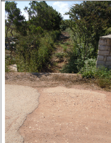
Il ponticello in corrispondenza dell'intersezione 3, vista del tratto a monte
