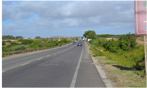
La strada provinciale all'ingresso del rilevato realizzato per superare l'avallamento in cui scorre l'affluente oggetto della presente documentazione
