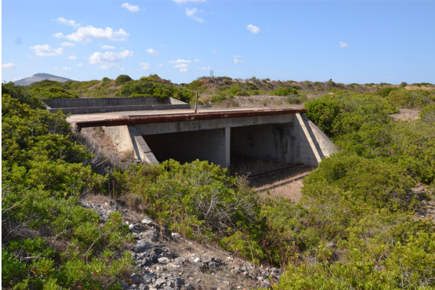
Una delle strutture realizzate nel compluvio naturale per il passaggio delle condotte verso serbatoi mai costruiti. A sinistra il tratto a valle e a destra il tratto a monte di una strada interna.
