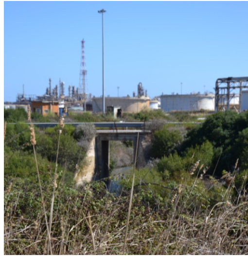
Il primo ponte, visto da monte, con caratteristiche geometriche idonee
