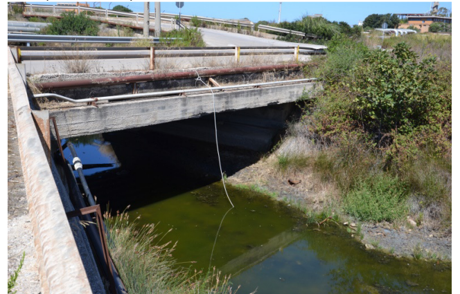
Foto del ponte (a sinistra da monte e a destra da valle) posto nel canale principale immediatamente a valle dell'immissione dell'asta principale e che non risulta adeguato a smaltire neanche le portate associate a periodi di ritorno di 50 anni.
