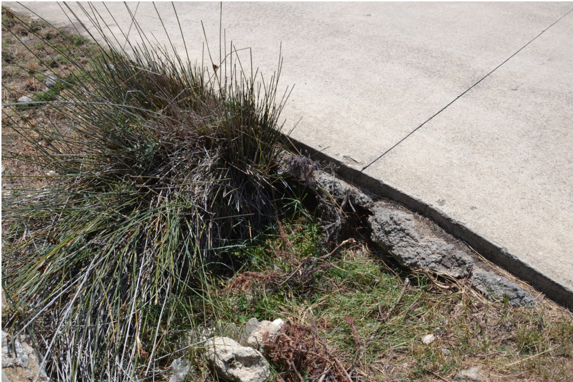
Dettaglio dell'imboccatura sotto la strada, tra il muro della foto precedente e la sede stradale
