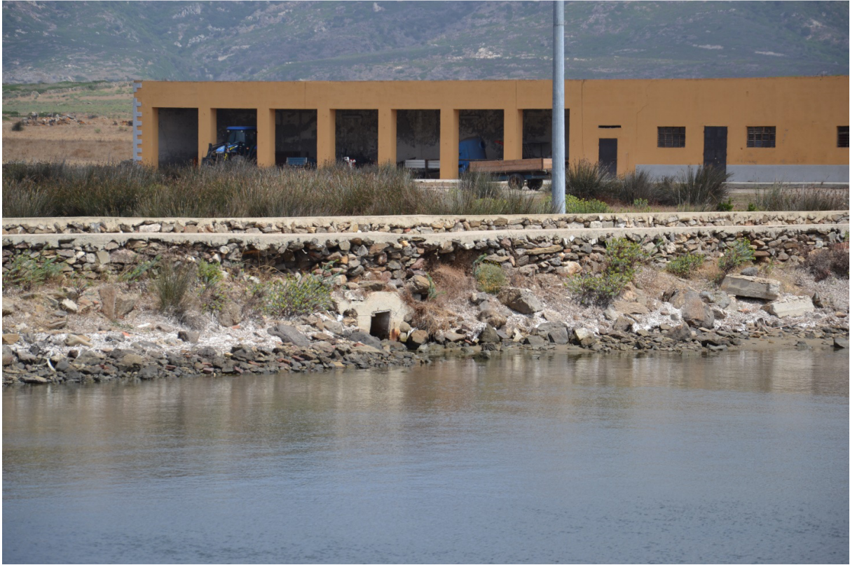
Lo sbocco a mare dello stagno, a valle della strada principale.
