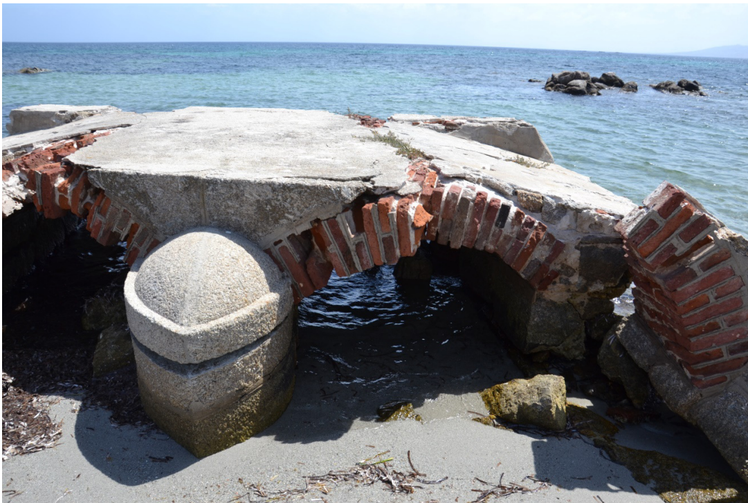
Particolare dello sperone, in granito, che caratterizzava un vecchio ponticello posto su una strada litoranea non più esistente, ora praticamente in mare a disostruzione dell'innalzamento del livello marino (o dell'abbassamento di questo tratto della Sardegna)
