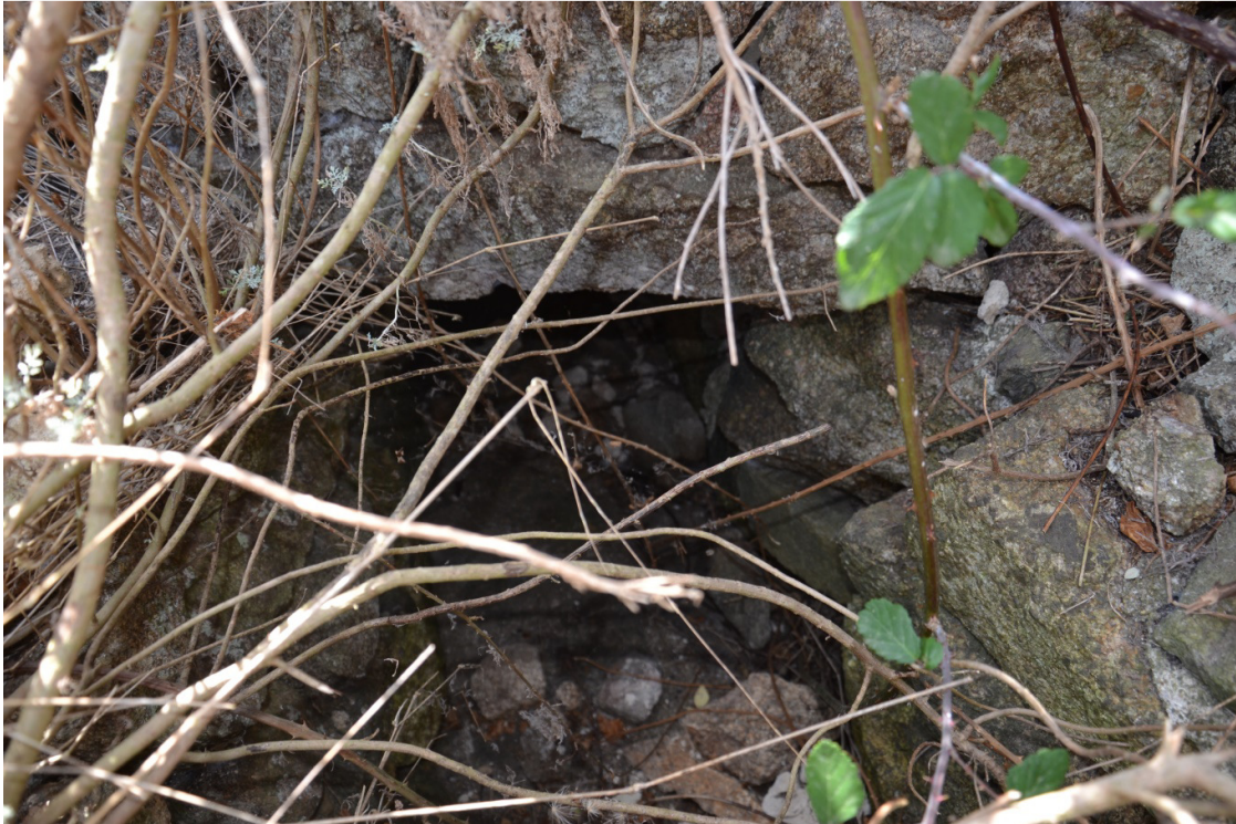
Particolare dell'ingresso del piccolo condotto realizzato sotto la strada documentata dall'immagine precedente
