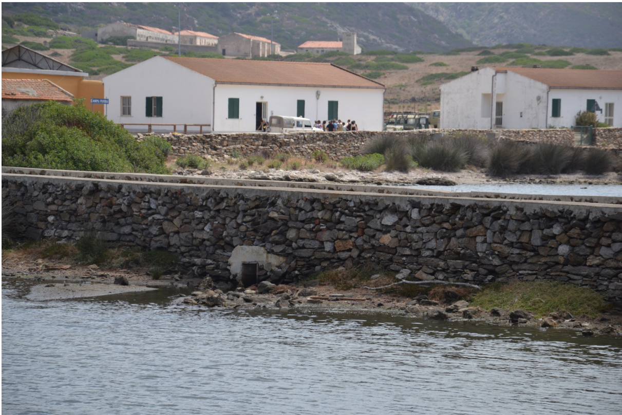
Lo sbocco a mare dello stagno, a monte della strada principale. La strada funziona come una traversa di regolazione e controllo degli scambi di acqua dolce-salmastro
