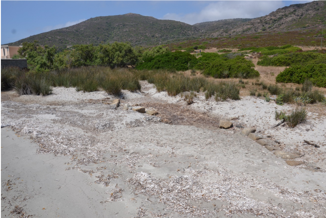
Lo sbocco dell'asta fluviale sulla spiaggia, si conservano tracce di vecchie sistemazioni dell'alveo in pietra.
