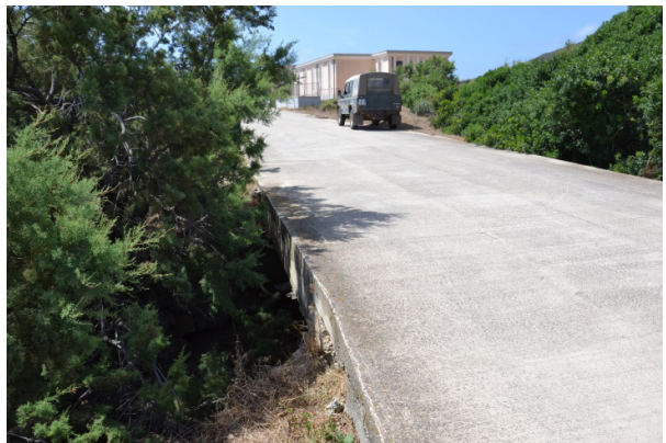
foto in basso a destra, il ponticello lungo la strada principale che attraversa l'Asinara, sullo sfondo gli edifici di competenza del ministero della difesa (carabinieri) Foto in basso a sinistra (una fase del rilievo della sezione del ponticello oggetto di analisi; il ponticello originale è stato allargato al momento della sistemazione della strada in calcestruzzo ora esistente.
