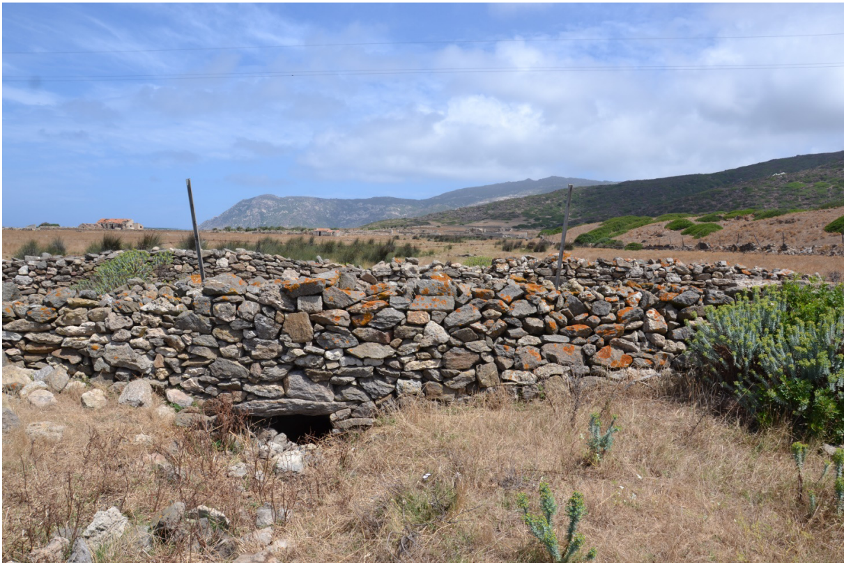
L'intersezione dell'asta fluviale sulla strada bianca a monte della strada principale.
