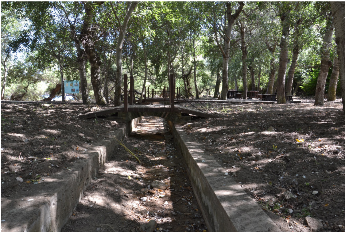
Il tratto dell'asta fluviale tra lo sbocco a mare e l'intersezione con lastrada principale. Il tratto è stato sistemato come parco per la sosta dei turisti. Sono presenti dei ponticelli pedonali in legno che attraversano il canale sistemato che addice le portate ordinarie al mare. Il canale non è in grado di smaltire le piene oggetto del presente studio.
