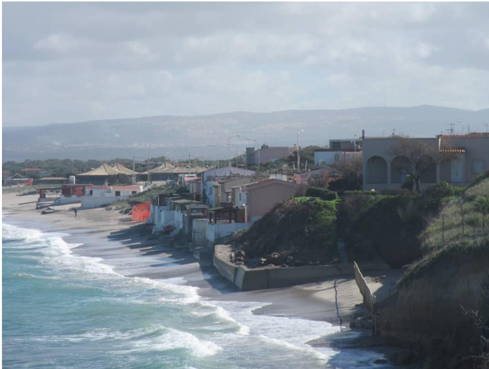
Figura 8. Villaggio di Abbaurrente, nella porzione occidentale della spiaggia di Platamona con evidenti i segni dell'erosione della spiaggia
