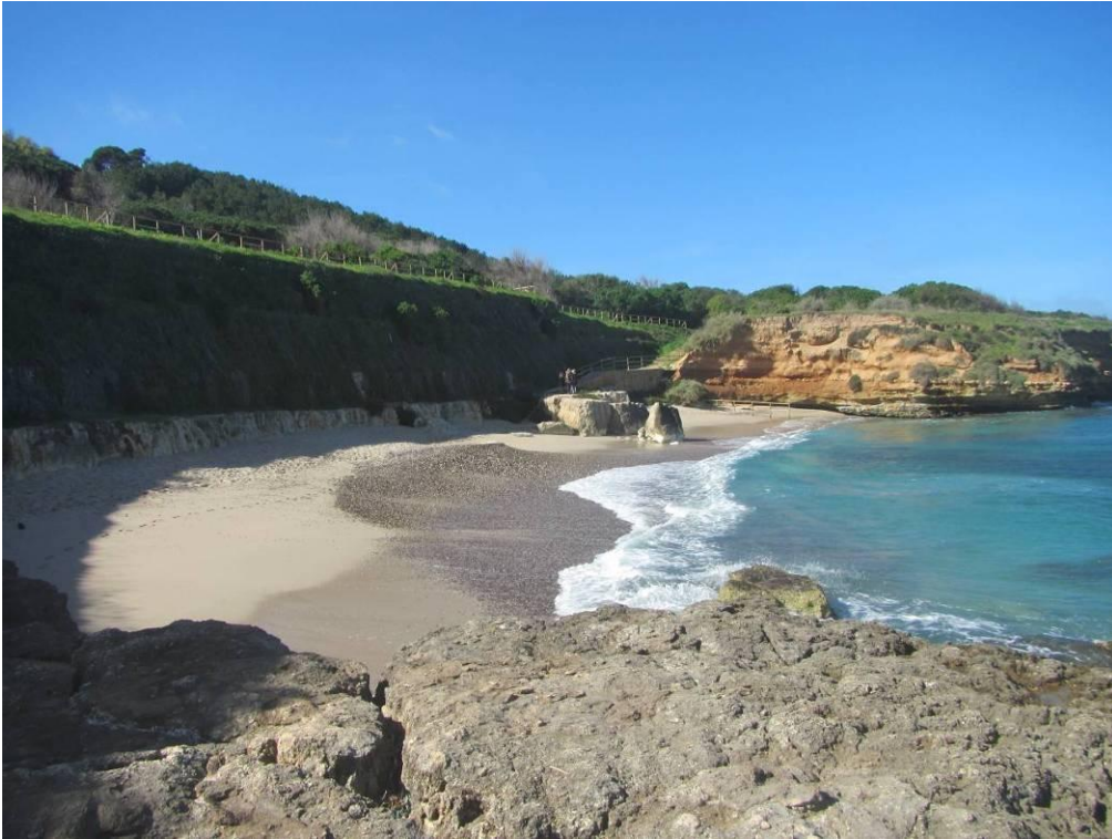
Figura 14. Porzione ovest della spiaggia di Farrizza. Si noti il tratto di promontorio roccioso con falesia attiva e, a sinistra, la scarpata stabilizzata con interventi del tipo "terre rinforzate"
