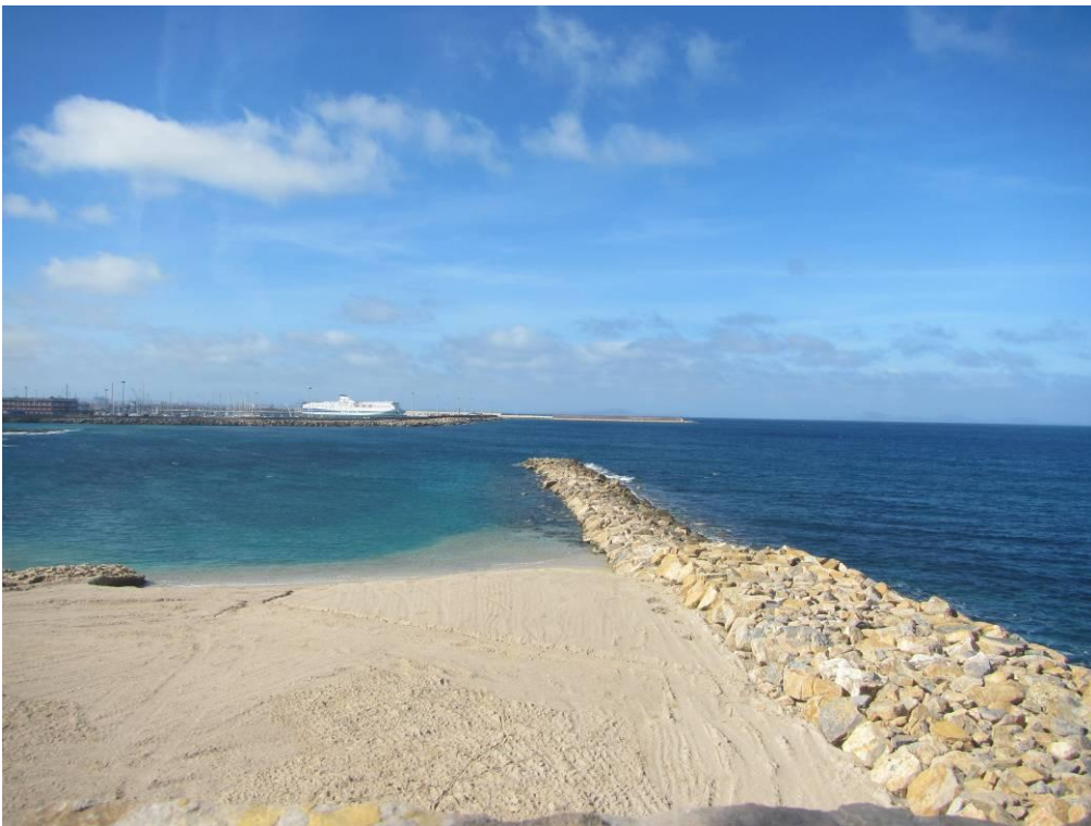
Figura 15. Il pennello artificiale e la falcata sabbiosa a seguito del ripascimento con inerti da cava nella spiaggia di Acque Dolci
