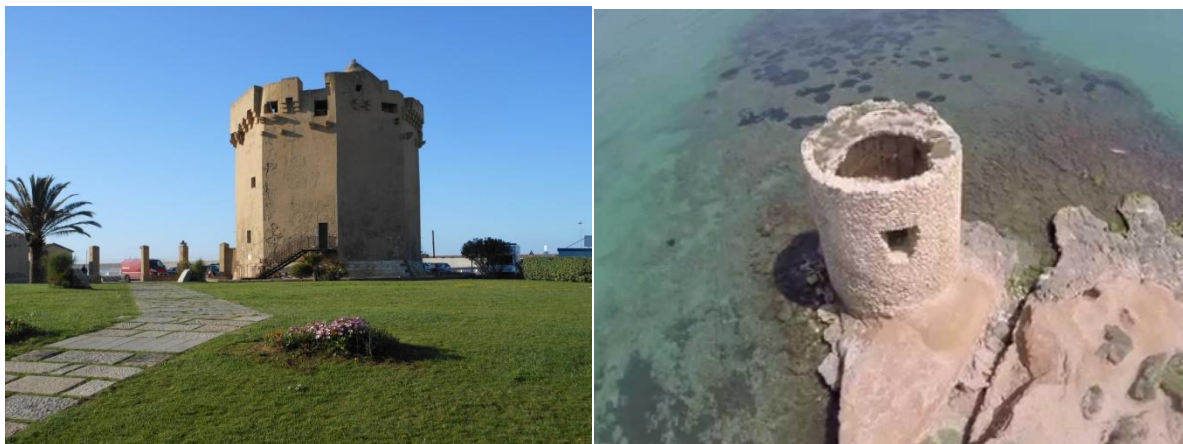
Figura 26. Torre del Porto e Torre di Abbacurrente
