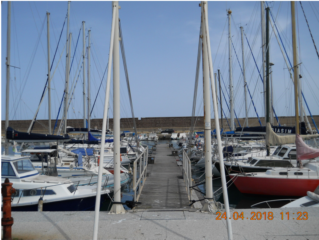
Terzo pontile composto da quattro elementi modulari
