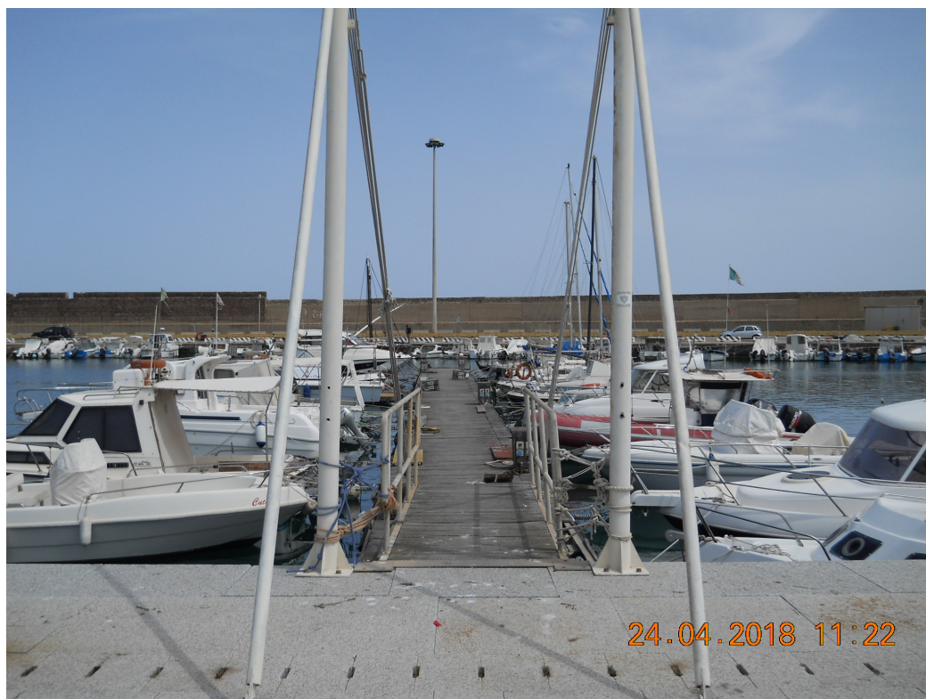
Secondo pontile composto da quattro elementi modulari
